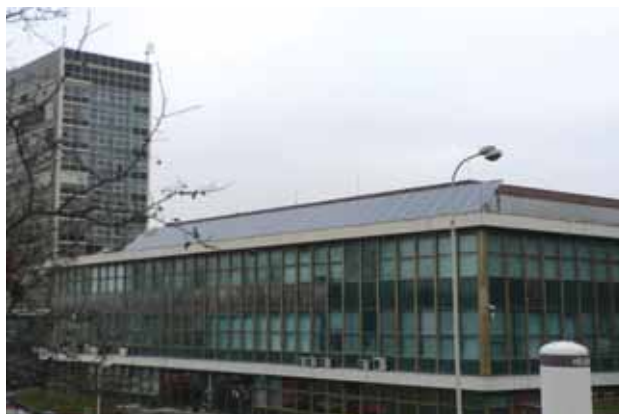
Obrázek 42: Instalace PV systému na MFF UK v Praze. Foto: EkoWATT
