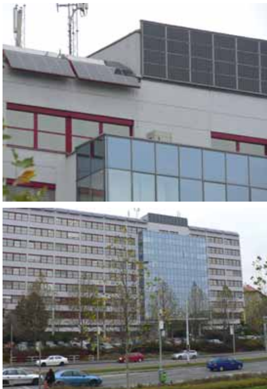
Obrázek 39: Fotovoltaický systém na budově MŽP ČR v Praze. Foto: EkoWATT
