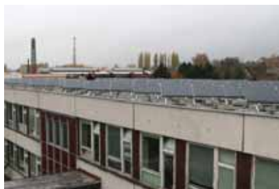
Obrázek 3: Panely na střeše základní školy na konstrukci s gravitačním kotvením. Foto: EkoWATT
